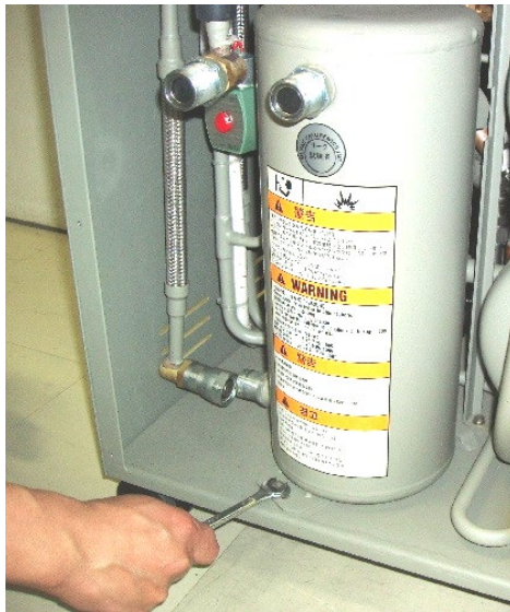
図 6-6 アドソーバ取付けボルトを外す
