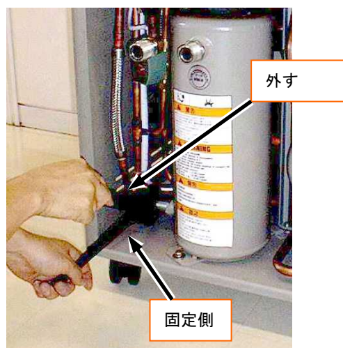
図 6-4 セルフシールカップリングを外す
