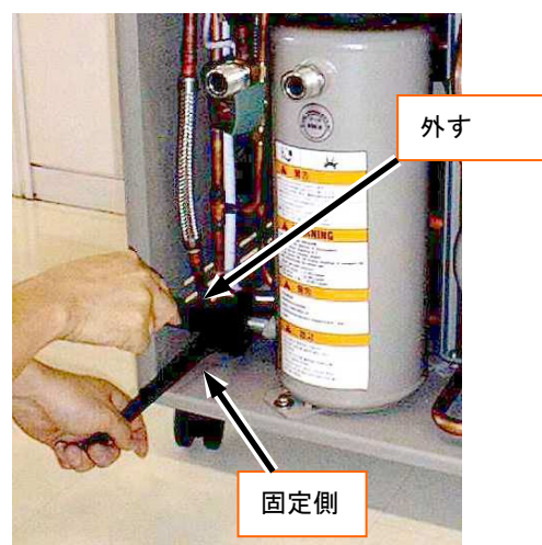
図6-4 セルフシールカップリングを外す
