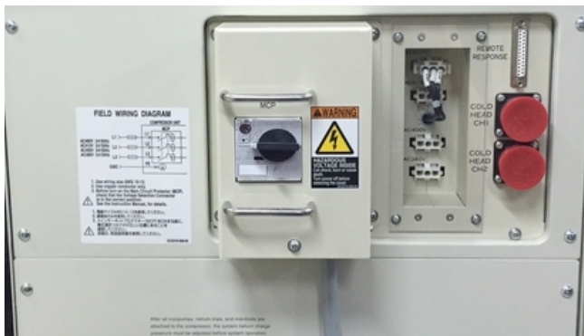
図 4-13 メインサーキットプロテクタのカバーを閉める
