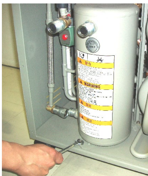
図 7-6 アドソーバ取付けボルトを外す
