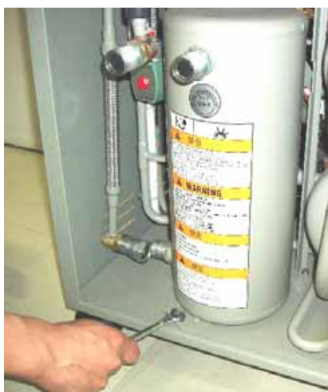
図 7-6 アドソーバ取付けボルトを外す
