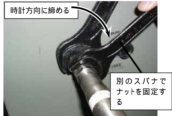
図 4-3 2本のスパナを使って締めます
