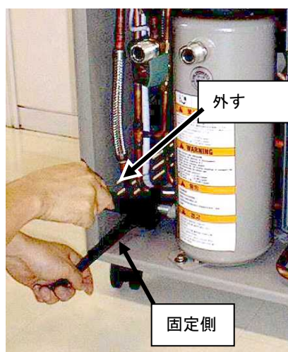
図 7-4 セルフシールカップリングを外す
