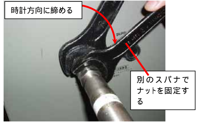
図 4-3 2本のスパナを使って締めます
