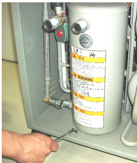
図 7-6 アドソーバ取付けボルトを外す
