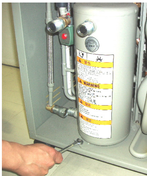
図 7-6 アドソーバ取付けボルトを外す(左)
